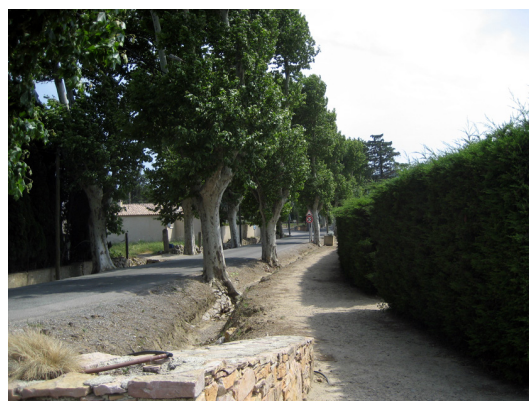
cheminement piéton avenue de la gare
