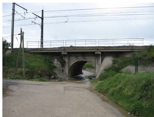
passage sous la voie ferrée
