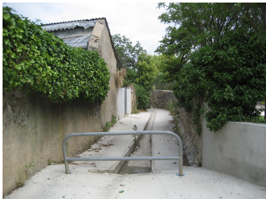
fossé-ruisseau rue République
