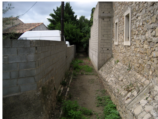
ruisseau-fossé rue Noble
